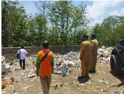
Pembangunan Pagar TPA Ambulu
