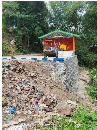
Pembangunan TPS Arjasa
