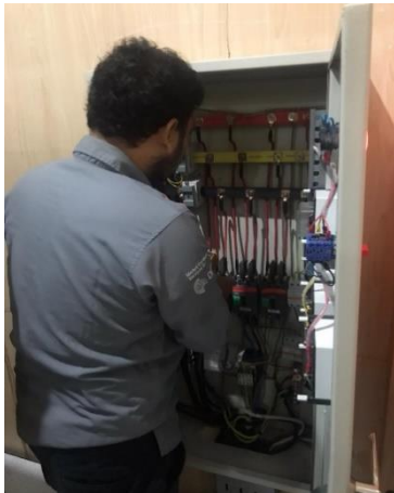
Penggantian Modul UPS Server
