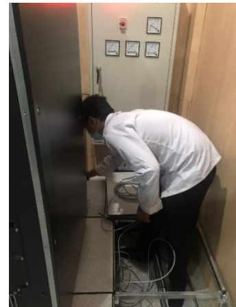
Pemasangan sensor ruangan server
