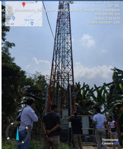
Tinjau Menara Telekomunikasi
