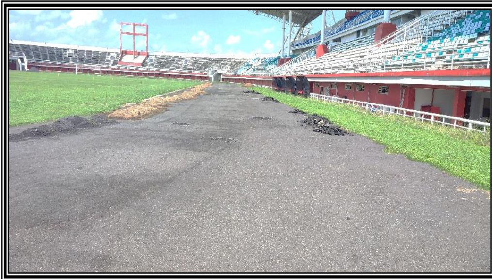
Lokasi : Gedung JSG (Lintasan Lari) Sebelum Kegiatan Rehab
