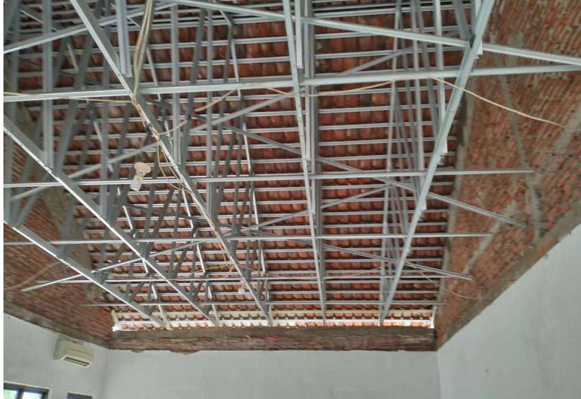
Rehabilitasi Gedung Kantor
