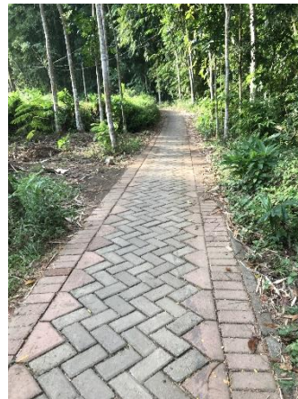
Pembangunan Jalan Lingkungan Kelurahan Kebonagung, Kaliwates
