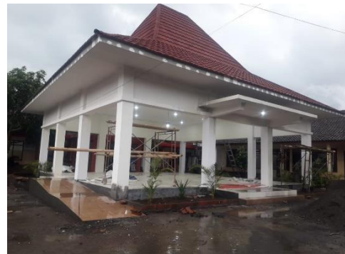
Rehab Gedung Kelurahan Summersari
